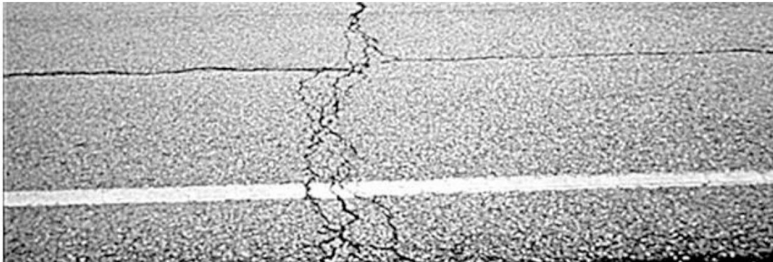
Ex: fissure tranverse sur une route
