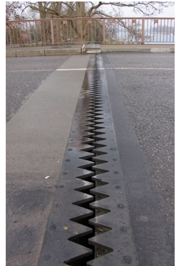
Joint de dilatation thermique d'un pont
